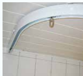
90°-Bogen an Holzdecke
